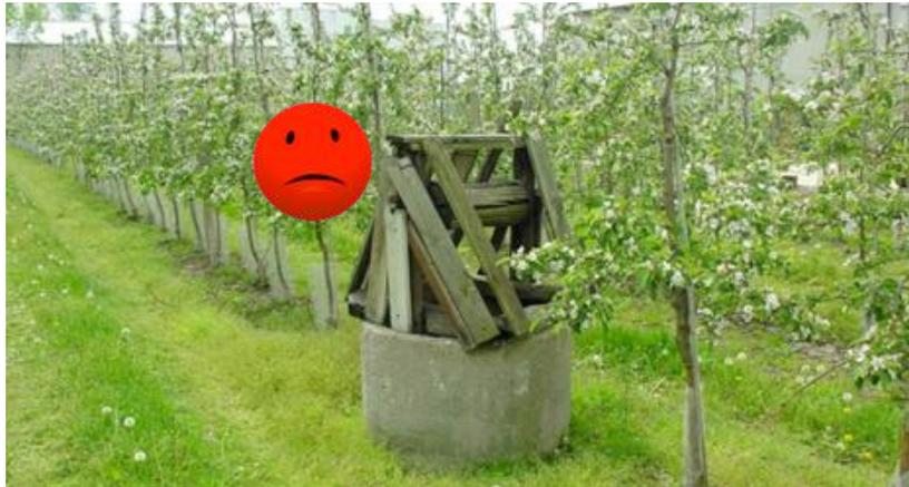
Fig. 69 – Pozzo non adeguatamente protetto (Foto ISK)
