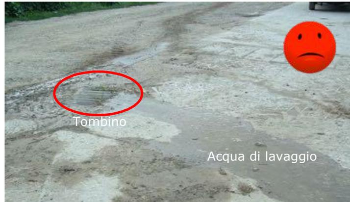
Fig. 98 – Acque di lavaggio immesse direttamente nella rete fognaria.
